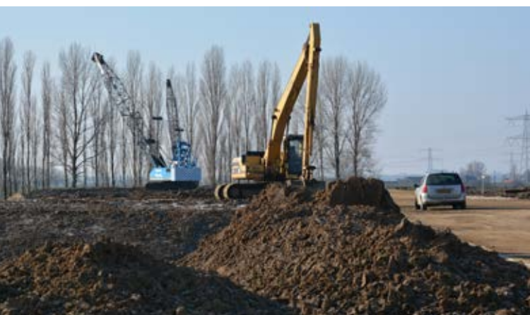
Voor de laagsgewijze opbouw van het kleidepot en het doorspitten van de klei wordt een hydraulische graafmachine en een dragline ingezet. Deze foto is gemaakt op het kleidepot op steenfabriek Huissenswaard.
