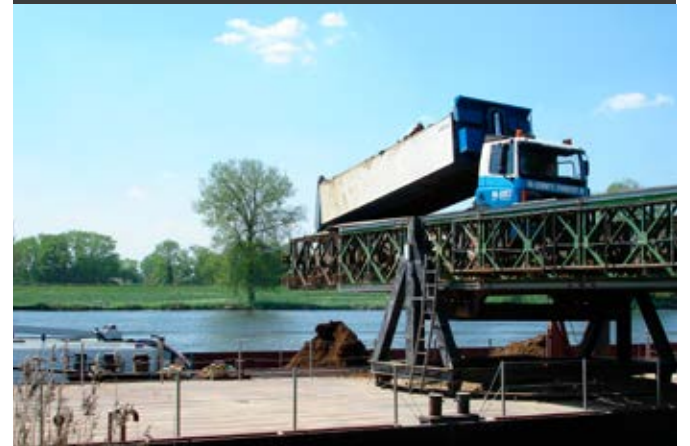
De klei wordt via een drijvend ponton met mobiele laadbrug in het schip gereden.
